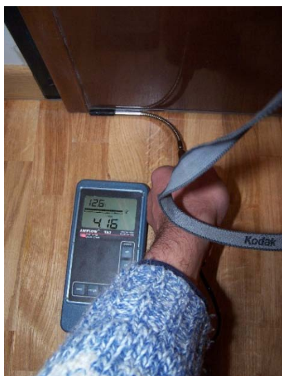
Figura 38 portoncino di ingresso
