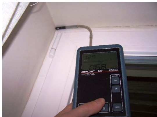
Figura 13 camera da letto infiltrazione modesta
