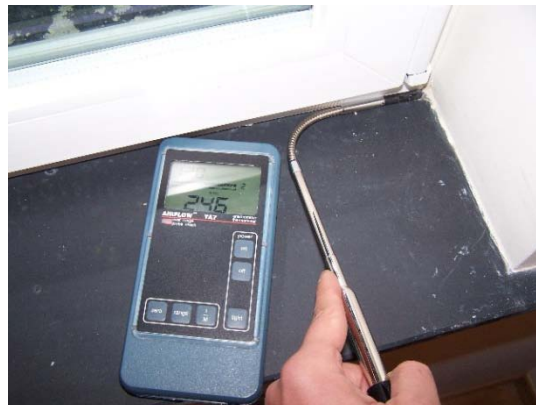
Figura 7 finestra soggiorno infiltrazione di aria
