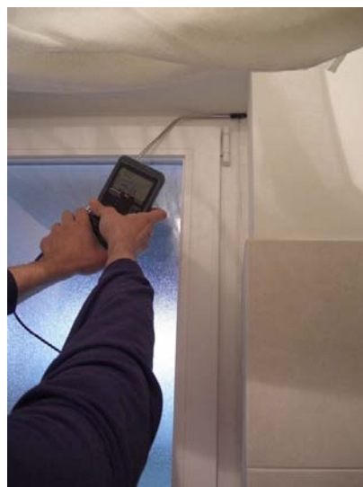
Figura 21 finestra del bagno
