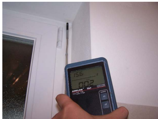
Figura 35 finestra del bagno
