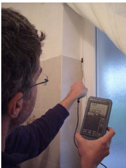
Figura 20 finestra del bagno
